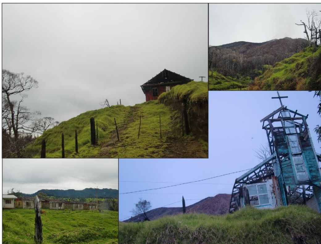
Figura 8: Daños causados por la lluvia acida constante en el sector noroeste del volcán Turrialba. Fotografías Yemerith Alpízar y Gino González.
