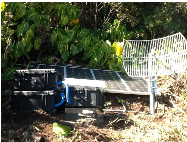
Figura 10. Ubicación de la estación sismológica VORI en el volcán Rincón de la Vieja que entró en funcionamiento el día 27 de febrero y la transmisión en línea comenzó el 20 de marzo de 2014.
