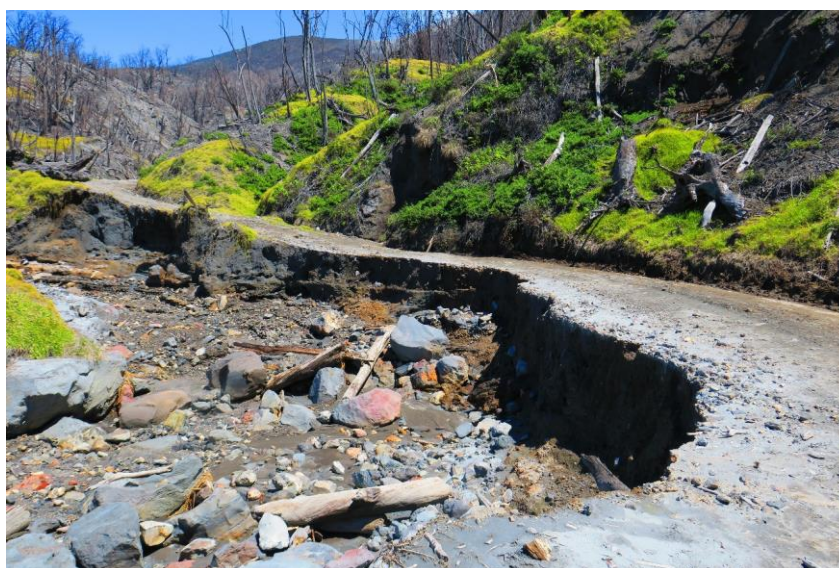
Figura 2: Continúa la erosión de la quebrada Paredes al camino hacia La Picada. El acceso a esta zona cada vez es más peligroso, sin embargo, los turistas ingresan en motos especialmente durante los fines de semana. Fotografía de Raúl Mora-Amador.
