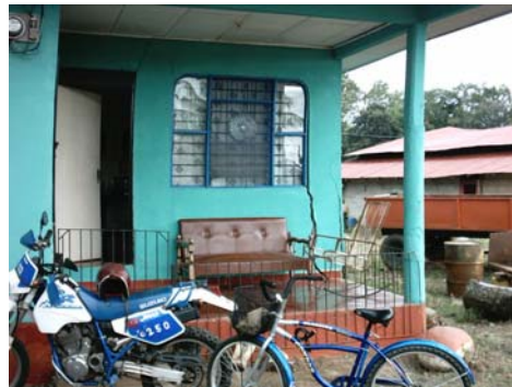
Foto 2: Casa agrietada en Parrita
