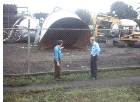
Foto 4: Colapso de tanques Palmatica
